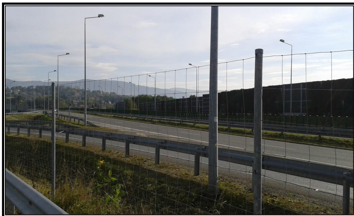
Fotografia 9 – Fragment drogi ekspresowej S1 Wykonał Szymon Mol
