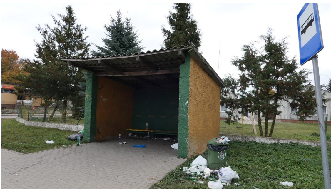
Fot.8 Przystanek autobusowy w Sarnowie (Maciej Dercz)
