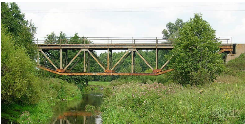
Fot.15 Most kolejowy na Szkotówce 40
