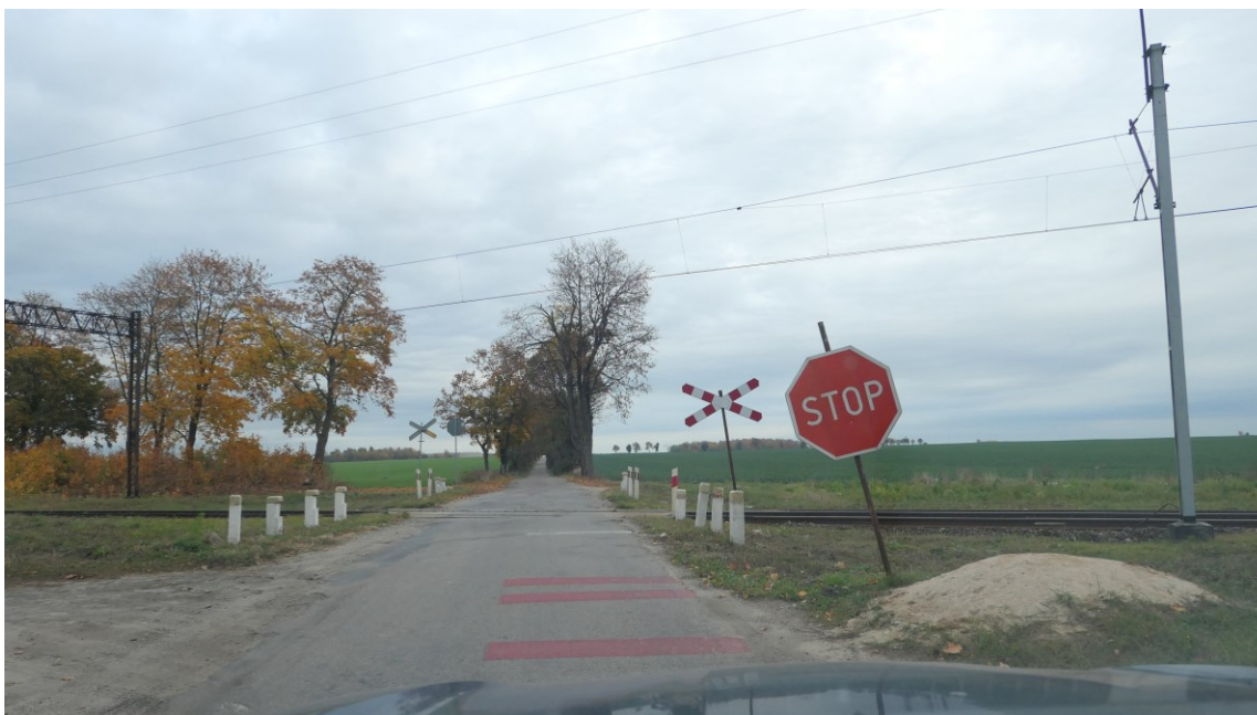
Fot.14 Przejazd kolejowy na drodze powiatowej nr 1550N (Maciej Dercz)
