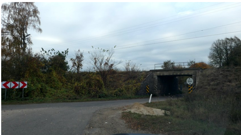
Fot.16. Wiadukt nad drogą powiatową nr 1587N (Maciej Dercz)
