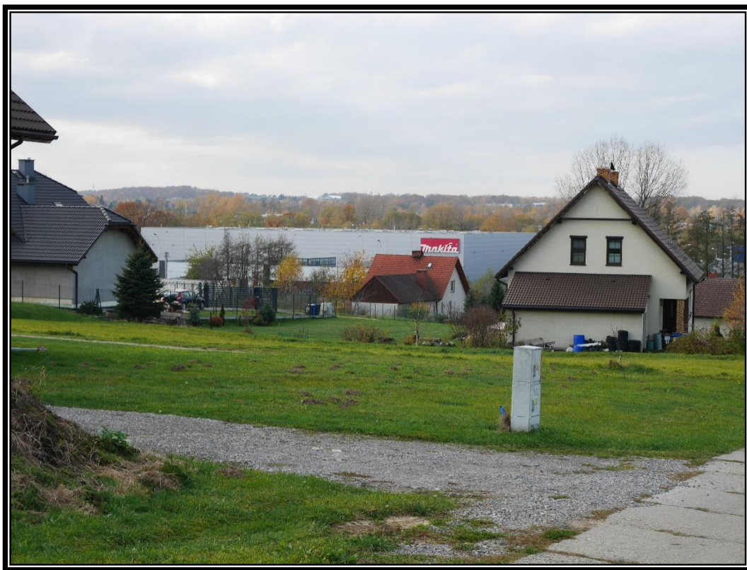
Fotografia 36 – Przykład kontrastu terenów przemysłowych z mieszkalnymi
