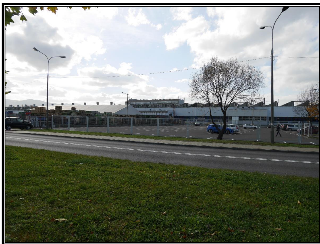
Fotografia 31 – Fabryki należące do kompleksu budynków Fiat Auto Poland
