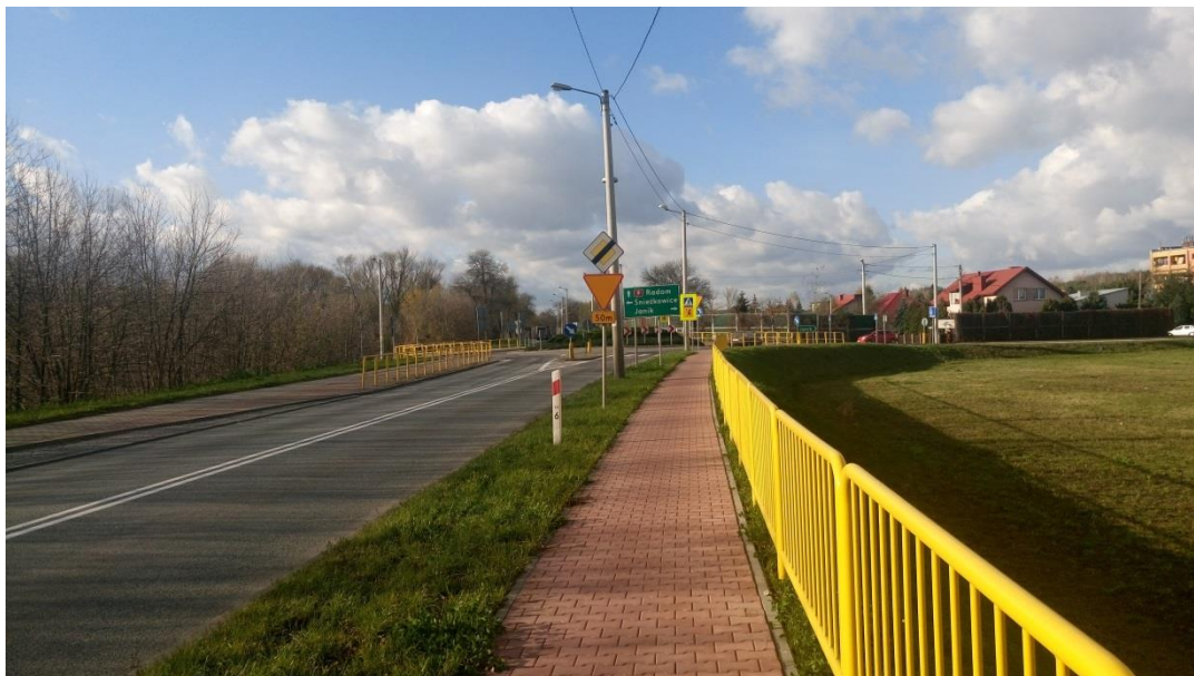
Fot. 6 Wyremontowany odcinek drogi krajowej nr 9 w pobliżu ronda w Kunowie oraz nowy chodnik wzdłuż trasy (Jakub Czuba)
