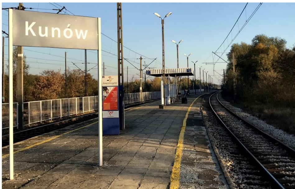
Fot. 5 Stacja kolejowa w Kunowie (Jakub Czuba)
