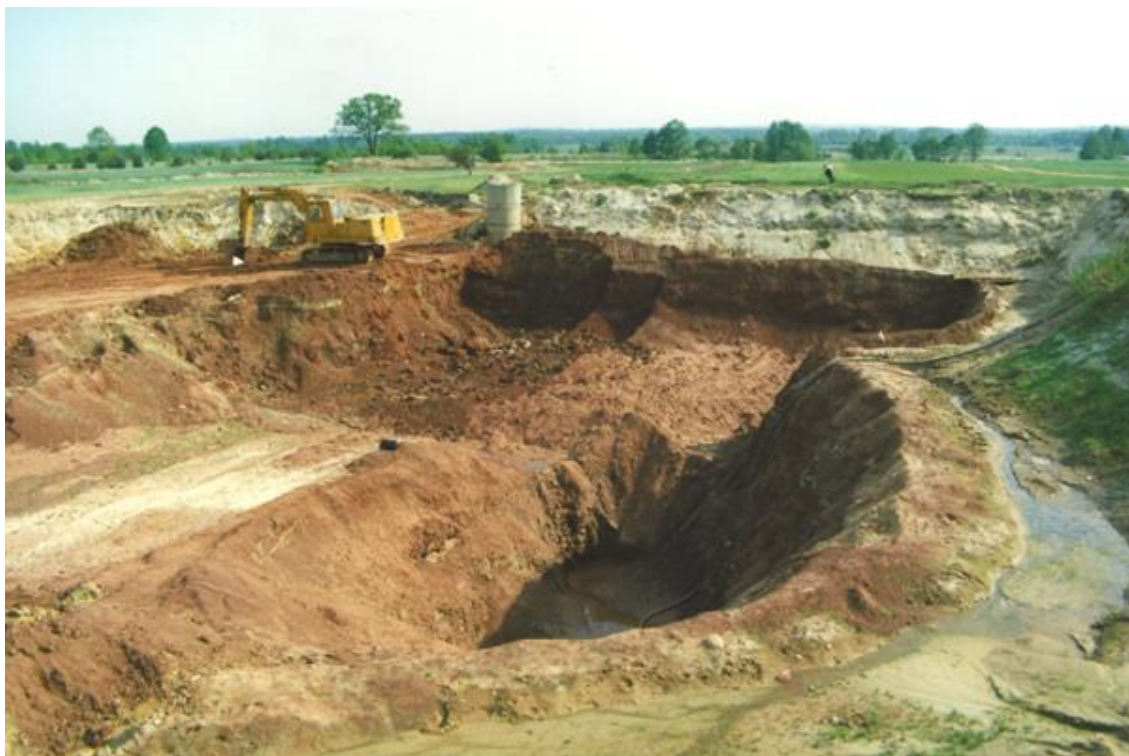
Fot 2: Początki wydobywania (źródło: zbiory archiwalne kopalni, 1993)
