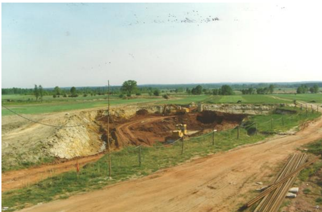
Fot 3: Początki wydobywania (źródło: zbiory archiwalne kopalni, 1993)
