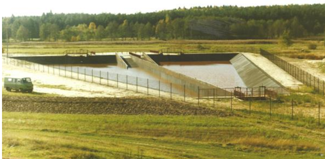
Fot. 13: Osadniki wody kopalnianej (źródło: zbiory archiwalne kopalni, 1993)
