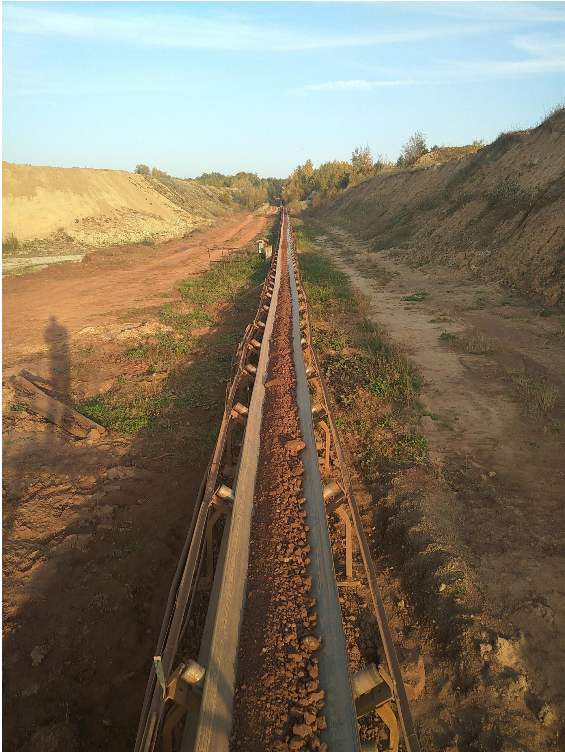
Fot. 7: Taśmociąg z gliną wyk. Piotr Kubiszewski
